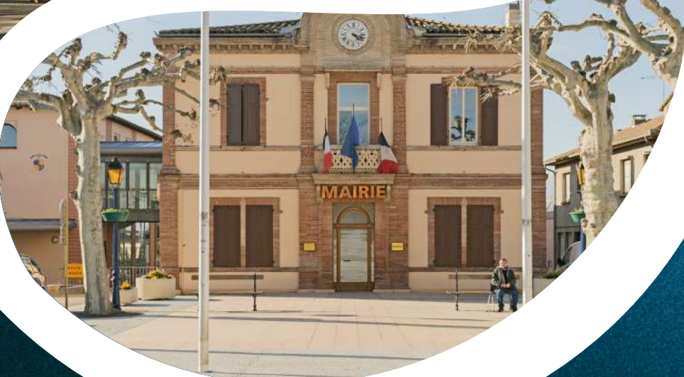
Halles de Castelginest
